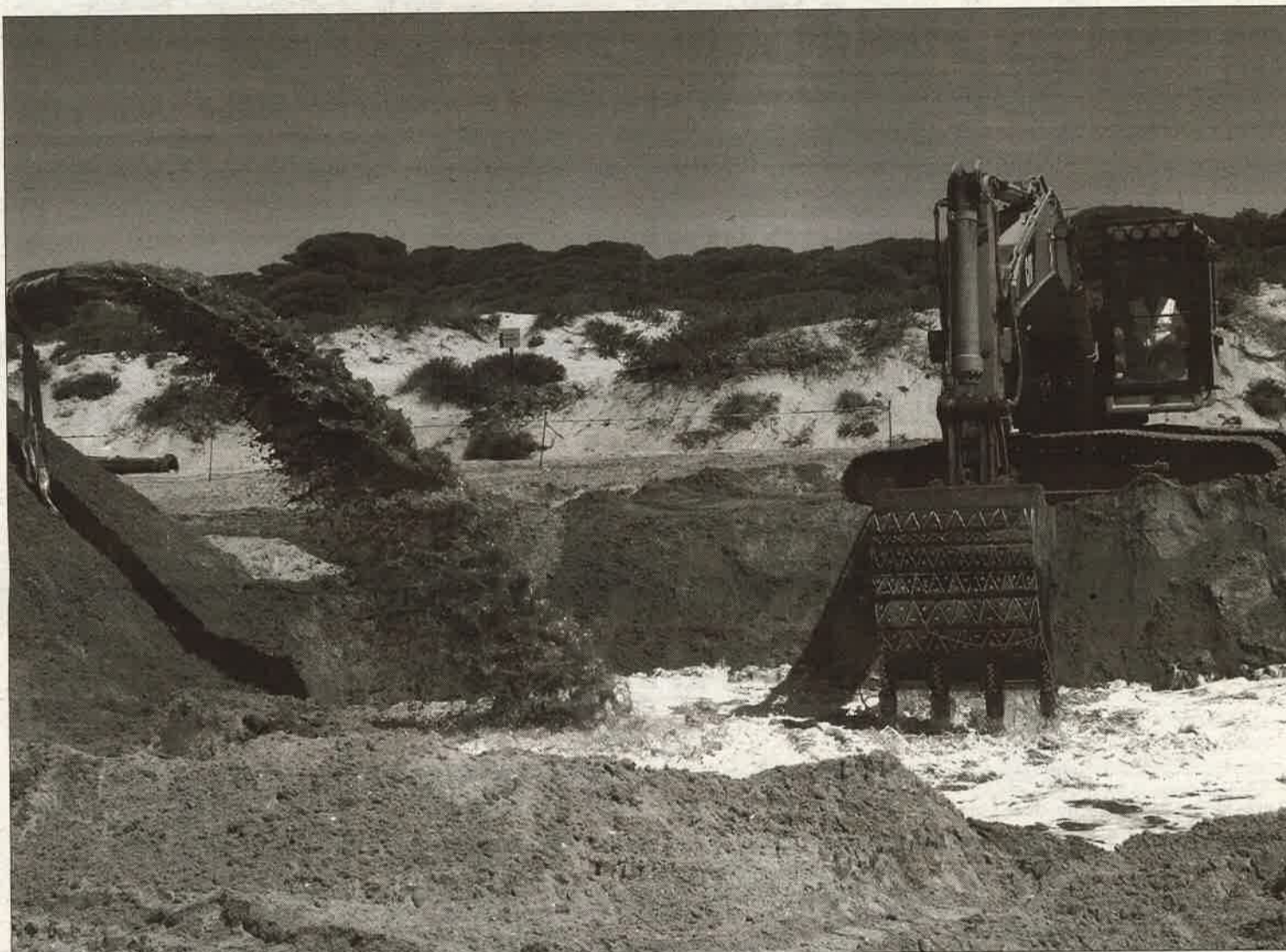
COORDINACIÓN. A la vez que la tubería escupe arena y agua, la retroexcavadora moldea ayer la balsa donde se vierten.
